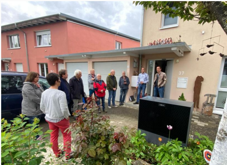
Besichtigung einer Wärmepumpe in Pfaffenhau Ost
