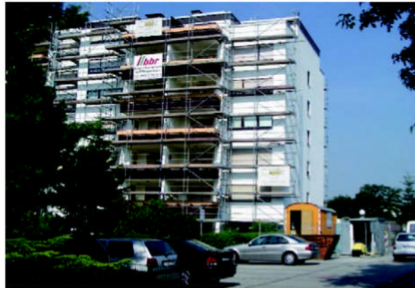
Kriftel: Renovierungsarbeiten im Bestand
